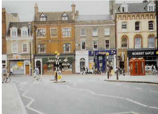
<그림 5.16> 횡단보도 앞 지그재그 노면표시
