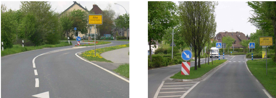
<그림 5.1> 도로 기하구조(선형) 변화 및 차로 폭 감소를 통한 자동차 주행속도 관리
